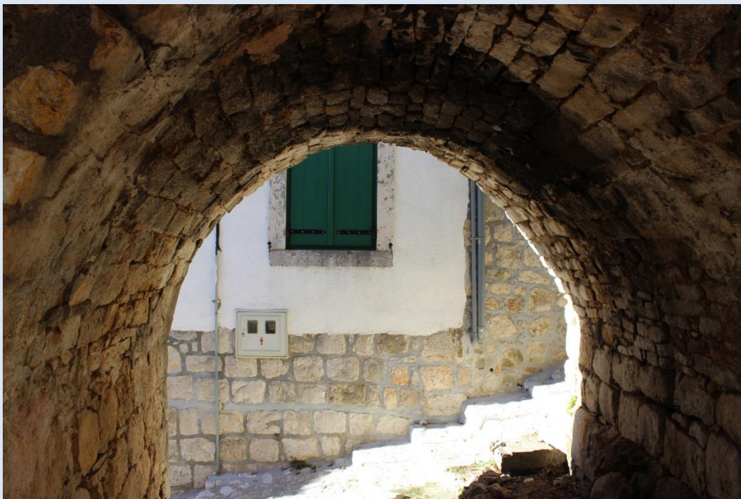
Slika 17. Kameni svod prolaza unutar naselja Lastovo
