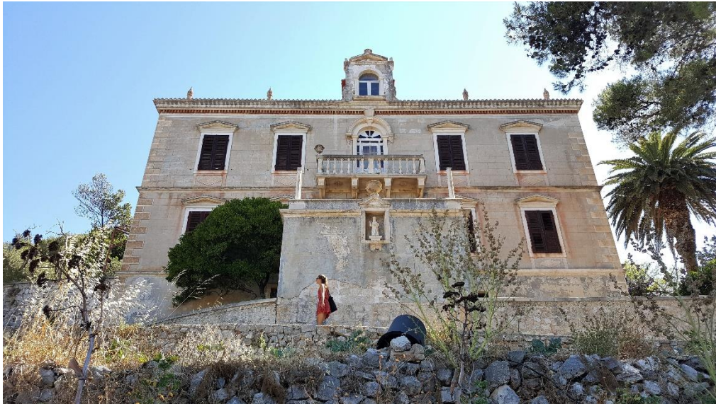
Južno pročelje kuće Garbini
