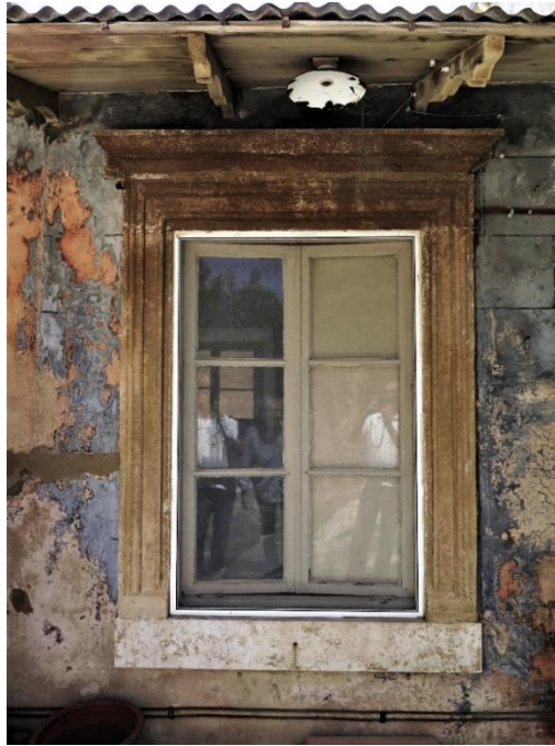
Kasnorenesansni prozor naknadno uzidan u pročelje kuhinje sjeverno od bloka kuće
