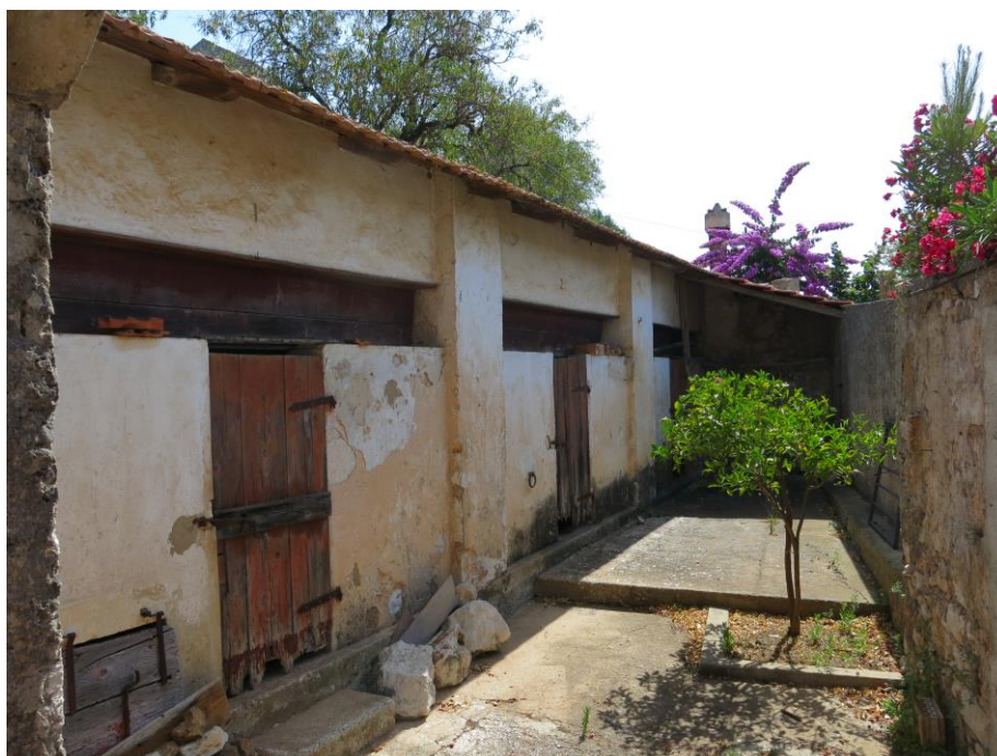
Prostor nekadašnjih štala u sjeveroistočnom uglu parcele
